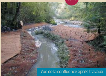
Vue de la confluence après travaux
