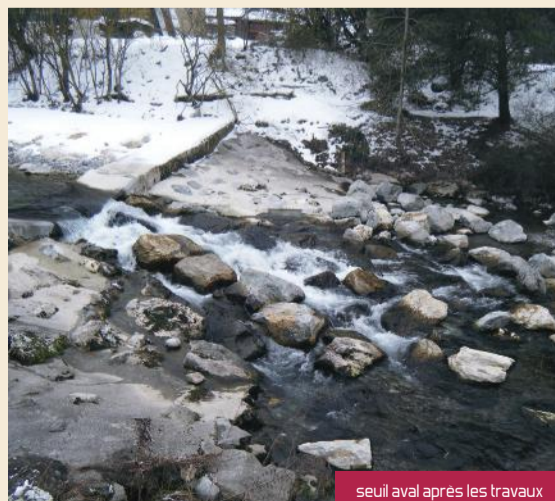
seuil aval après les travaux
