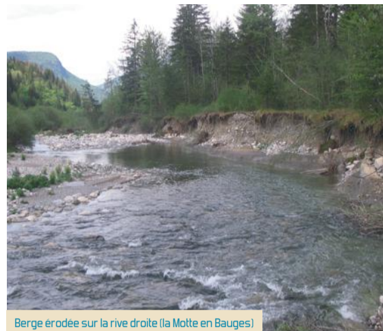
Berge érodée sur la rive droite (la Motte en Bauges)
