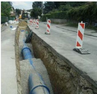
Par exemple, **la commune de Vienne (38) au sud de Lyon vise une économie de 1,3 million de m<sup>3</sup> d'eau potable par an** en remplaçant 6 km d'une canalisation vieille de 40 ans et qui dessert 9000 foyers. **Le rendement du réseau** devrait passer de 63 à **80 %** après les travaux qui s'achèveront en 2019, pour un montant de 5,3 M€ dont 4,3 M€ d'aide de l'agence de l'eau.
