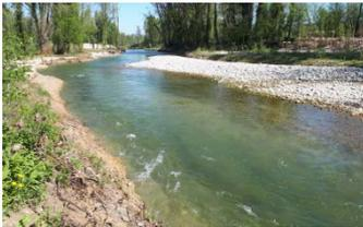
Sur la Leysse en Savoie, Chambéry Métropole, maître d'ouvrage, et le Cisalpb ont piloté des travaux de restauration de la rivière sur 2,8 km dans l'agglomération (pour 18 M€ au total, dont 4,5 M€ d'aide de l'agence de l'eau). Les travaux, en milieu urbain, ont adouci les berges et remodelé le lit. La rivière a également retrouvé ses méandres grâce à des zones de remblais « reconquises », à un recul des digues, à la plantation d'arbres et à la création de 5 ha de zones humides... Au-delà
