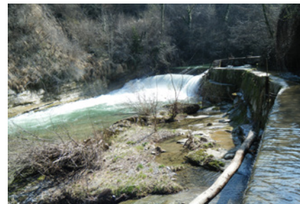
▲ Le seuil et l'ancienne prise d'eau (à droite).
