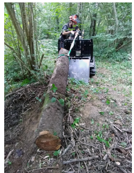
Évacuation d'un embâcle.
