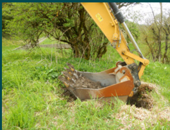
Pelleteuse excavant la renouée au bord du Chéran.
