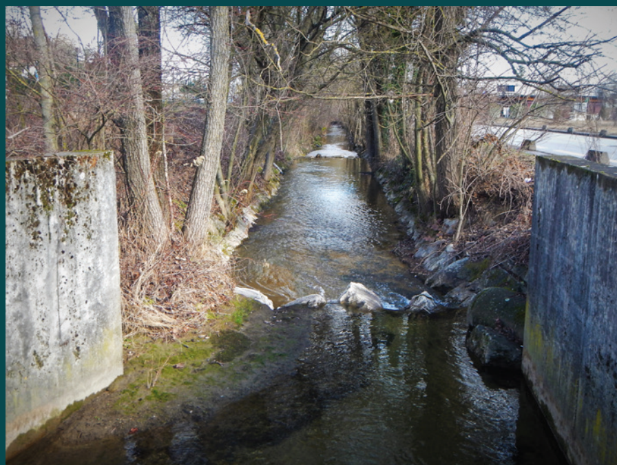
▼ Le Dadon rectifié et bétonné dans la traversée de la zone d'activité de Rumilly.
