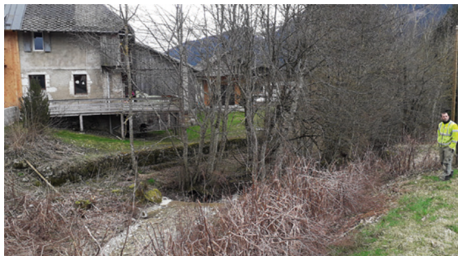
▲ Le ruisseau de Mellesime avant restauration.
